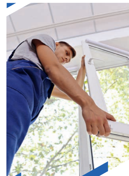
Pose de fenêtre par un artisan © Adobe Stock
