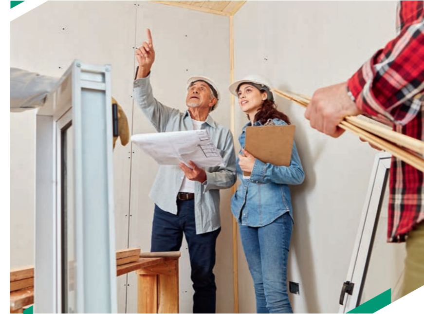
Réalisation d'un audit de chantier © Adobe Stock
