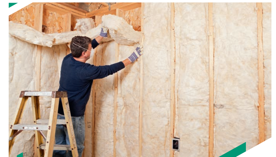
Chantier de rénovation énergétique © Adobe Stock
