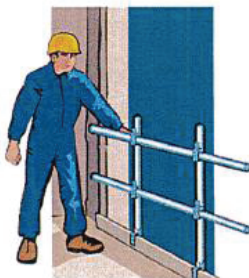
Ouverture sur le vide = garde-corps temporaire
