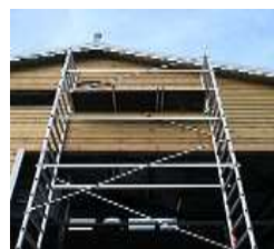
Montage et utilisation échafaudages
