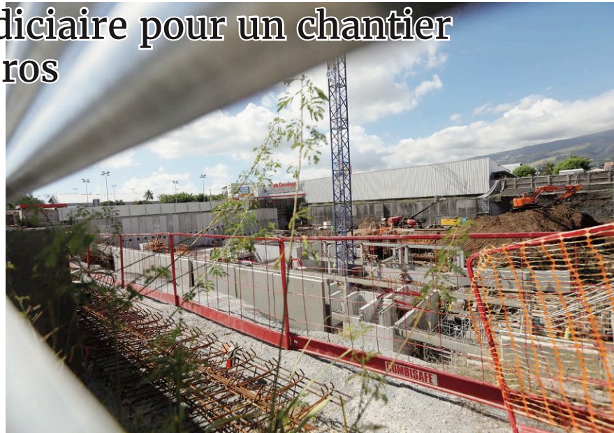
DLC Construction demande au tribunal d'ordonner une expertise judiciaire globale sur les conditions d'exécution du marché de la Sodiad (photo L-Y.L).
