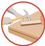
2 Pose de la cale de haute pente
