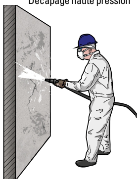
Décapage haute pression
