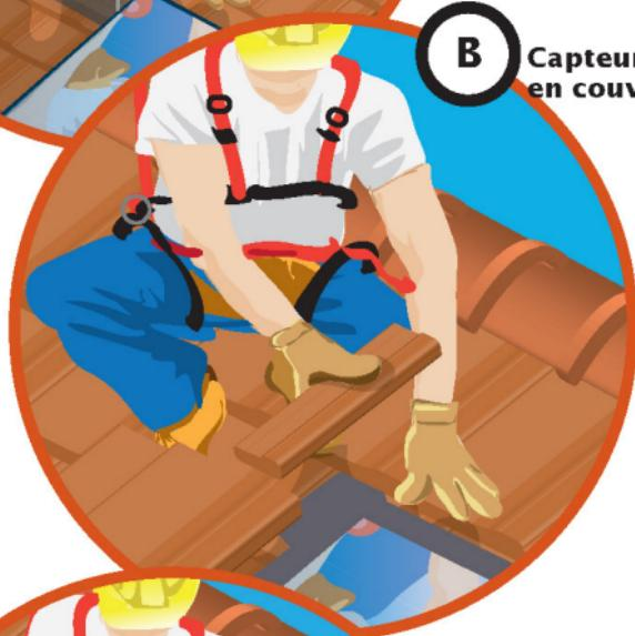
**B** Capteur semi-incorporé en couverture
