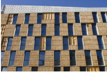
Isolation par l'extérieur en paille, sur un bâtiment à Nantes, en 2017. © Jacques LOIC / Photononstop via AFP
