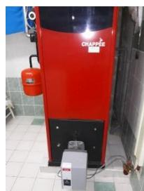
Les chaudières classiques, conçues pour fonctionner avec du fioul standard, ne sont pas toujours compatibles avec le biofioul sans modifications préalables. L'emploi de ce carburant dans une installation inadaptée peut causer des dépôts, des dysfonctionnements, voire une panne complète du système de chauffage.
