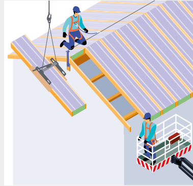
▲ Pose du dernier panneau sandwich ou caisson chevronné.
