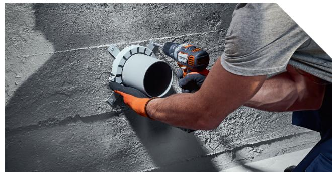
Et une gamme complète de produits chimiques spécialisés pour étanchéifier les conduites de tuyaux à travers les murs et les plafonds pour la protection incendie conformément à la législation.
