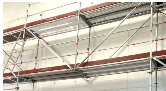
Franchissement en diagonales
