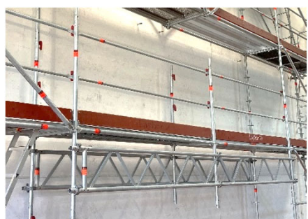
Franchissement avec poutre LW
