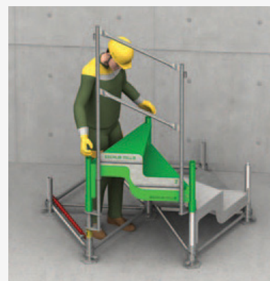
4 - Pose d'un module 2 marches 3
