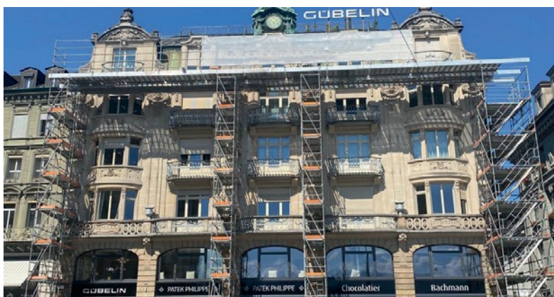
Protection grillagée sur un immeuble commercial de Lucerne (Suisse) : les boutiques et leurs vitrines restent visibles des passants.
