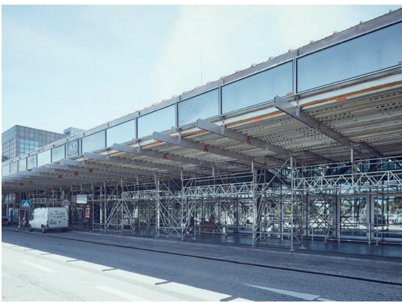
Traitement d'une toiture en saillie d'un aéroport (aéroport de Hambourg, Allemagne)
