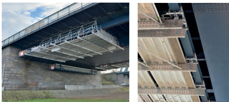
Plateforme mobile de maintenance du pont de Maxau (pont sur le Rhin près de Karlsruhe, Allemagne).
