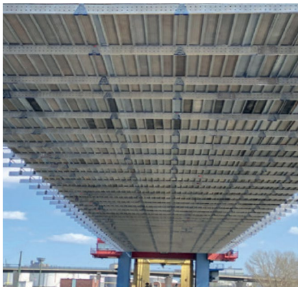
Pont levant ferroviaire du port de Hambourg (pont Kattwyk) : le nombre réduit des suspentes a permis d'éviter l'interruption de fonctionnement du tablier mobile pendant les travaux.
