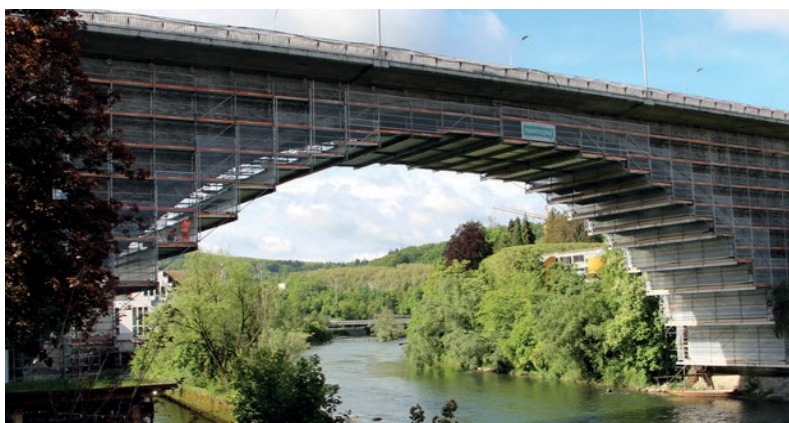
Viaduc de Baden (Suisse) : FlexBeam au service d'un équipement respectant le contour de l'arche pour une inspection au plus près de l'ouvrage.
