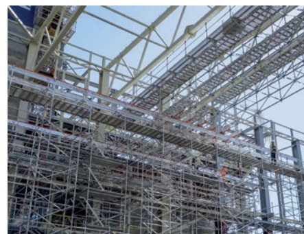
Structure mobile auto-stable utilisée pour la création d'un site industriel en Lituanie.
