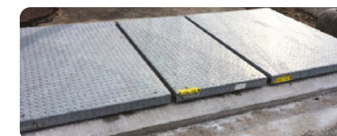
Trappe de fermeture
