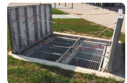
Trappe de fermeture
