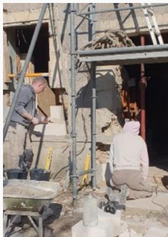
Pose de l'entourage de la porte et de la fenêtre en Tuffeau.
