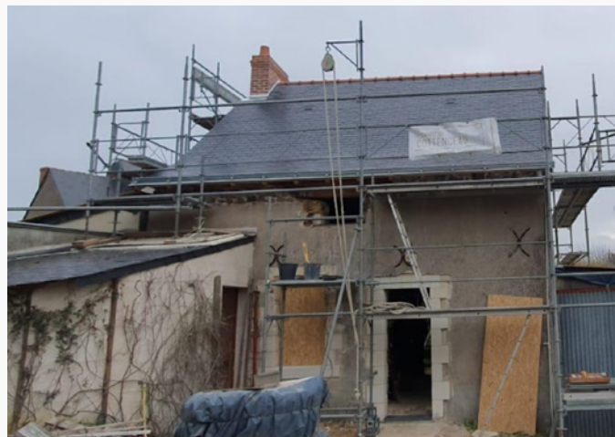
En cours de chantier.
