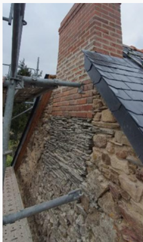
Réhausse de la souche en brique.
